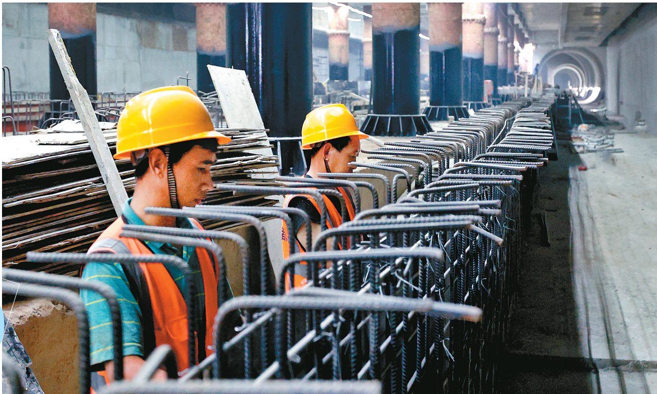
西安地铁8号线新植物园站施工作业基本都在地下 首席记者 王健 摄
